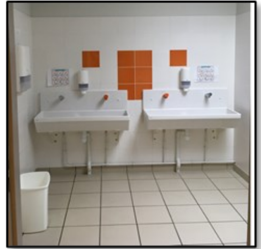
les toilettes intérieures
