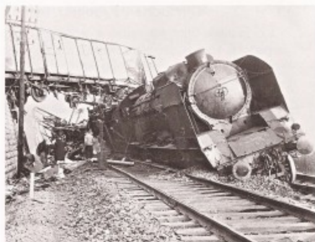
Sabotage organisé par la Résistance intérieure française (destruction d'une voie ferrée par la Résistance au Villars, Saône et Loire, 4 mars 1944)
