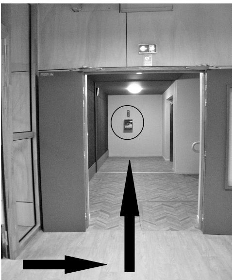
cage d'escalier centrale
