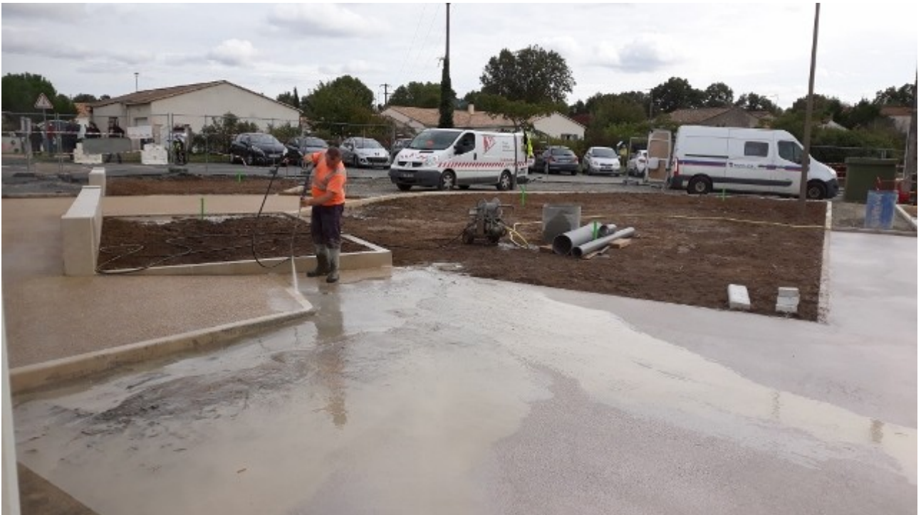
Un jet d'eau pour nettoyer le béton et voilà ! Comme c'est beau !
