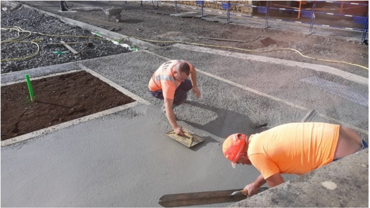
Puis le béton est lissé
