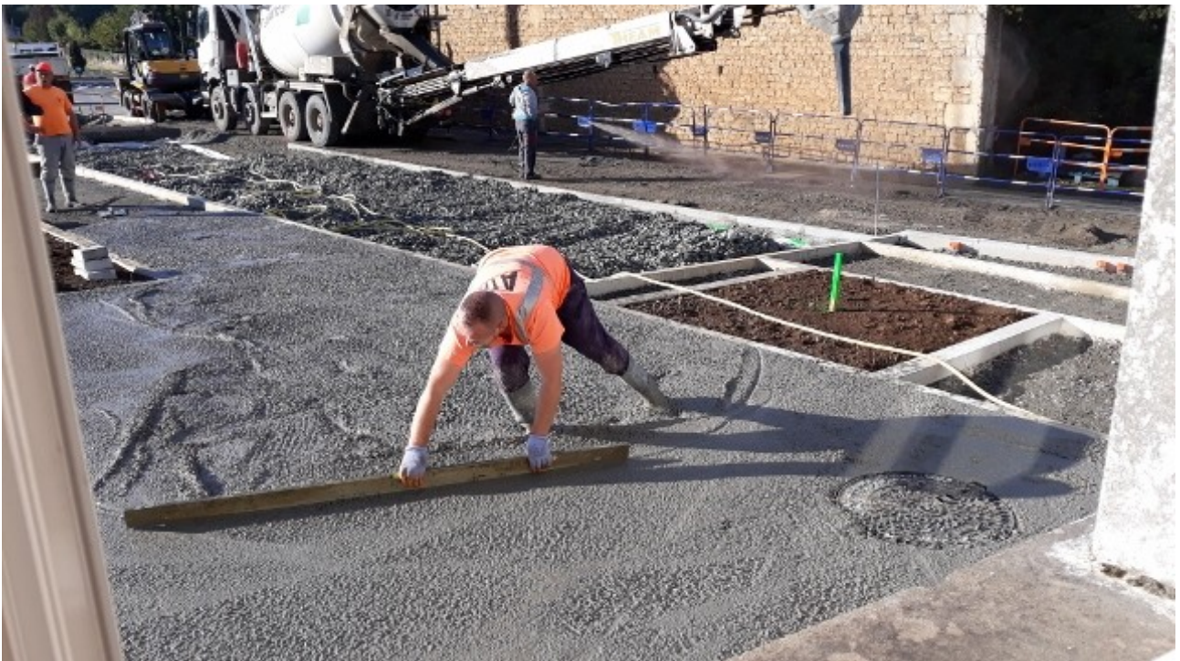
Un ouvrier étale le béton avec une grande règle
