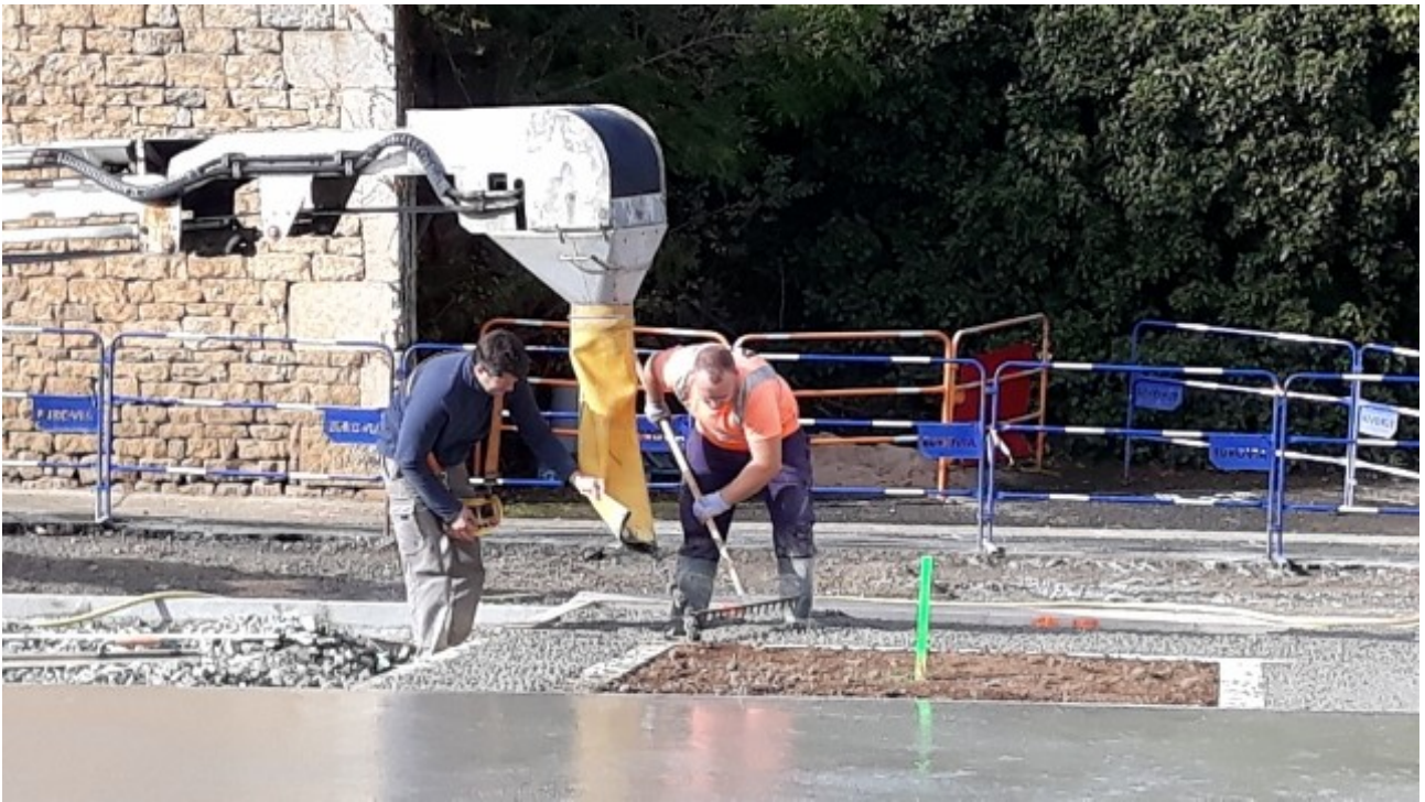
Un ouvrier le répartit avec le râseau
