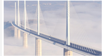
Le viaduc de Millau
