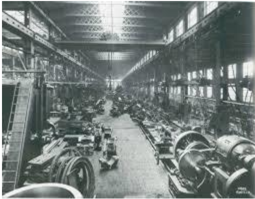
La salle des machines
